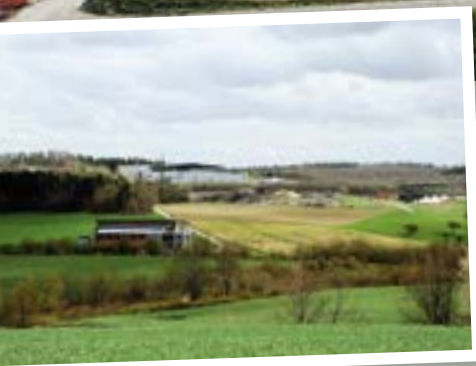
Derzeitiger Zustand der Deponie Blick aus Nordwesten
